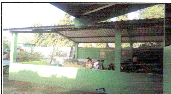
Foto 4: Reparación y levantado de muro de Block
